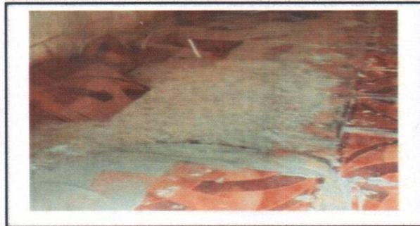
Foto 6: SE OBSERVA EL PROCESO DE SUSTITUCION DE AZULEJOS
