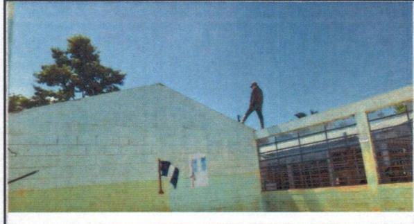
Foto 2: SE OBSERVA EL DESMONTAJE DE LA ESTRUCTURA DE TECHO.
